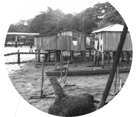
Casas del Firme San José
